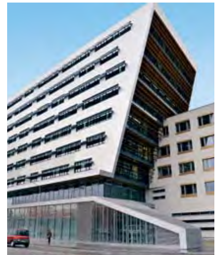
Im STAR22 befindet sich das Rechenzentrum
